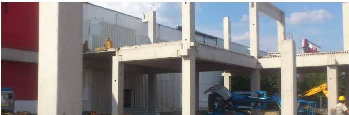
A födémgerendák a legtöbb esetben négyzetű keresztmetszetűek, de sokszög alakú, illetve „L” profil is kialakítható. A gerendákra támaszkodó födém, illetve födémelemek monolit koszorúja együtt dolgozik a gerendával. A teherbírási igényektől függően tervezhetők lágyvasas és feszített gerendák is.
