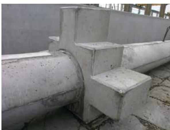
Az előregyártott konzolok alkalmazhatók zsaluzási korlátok esetén, monolit pillérekhez / falakhoz való csatlakozás illetve kivitelezési ütem és megvalósíthatóság biztosítása érdekében. A fogadó szerkezet betonminőségétől függetlenül nagyszilárdságú konzolok gyárthatók, alkalmazásuk esetén monolit szerkezettel nincs szükség a zsaluzat kialakítására, csupán az elhelyezési rés kihagyására.
