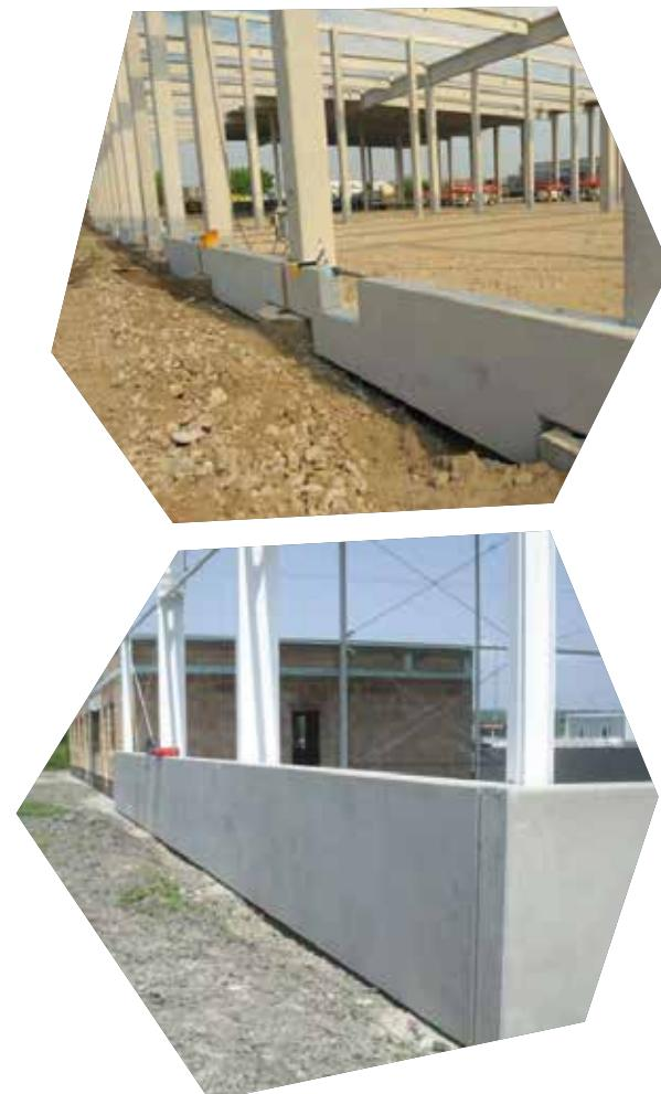
Az előregyártott falpanelek, illetve lábazati elemek készülhetnek hőszigeteletlen tömör, illetve hőszigetelt háromrétegű keresztmetszettel. A maximális geometriai méreteket a szerelési és szállíthatósági korlátok határozzák meg. A panelek vízszintes rögzítése történhet csavarozott vagy hegesztett kapcsolattal. A falvastagságok és a hőszigetelés vastagsága az aktuális igényekhez igazíthatók.
