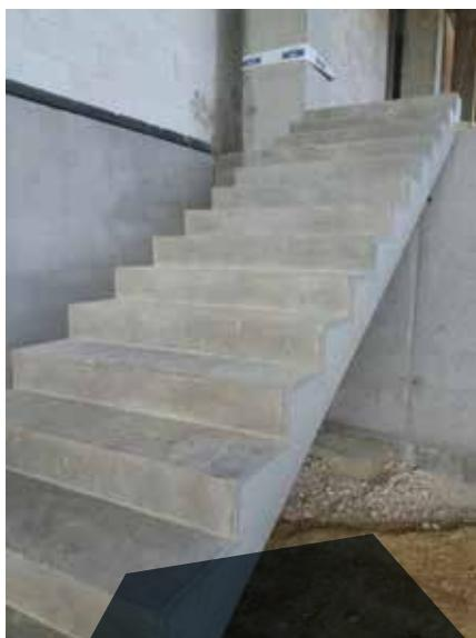
Az előregyártott lépcsőelemeket a monolit megoldással szemben a gyors helyszíni kivitelezés a monolit betonozás elkerülésének köszönhetően, nagy precizitás, méret pontosság és széleskörű alkalmazhatóság jellemzi. A fellépések és a lépcsőlemez geometriája is változó lehet a statikai és építészeti igényeknek megfelelően.
