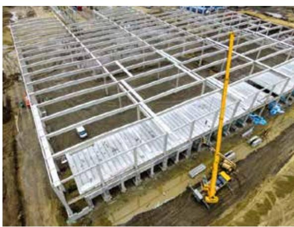
Az üreges födémelemek „slipformer” technológiával 120m hosszú gyártópadon készülnek. A födempallók tetszőleges hosszra, szükség esetén ferdevágással is darabolhatók. Az elemek nagy teherbírású közbenső és tetőfödémek kivitelezésére alkalmazhatók. A típuskeresztmetszetek 18,5cm, 20cm, 25cm illetve 30cm magasságúak, C40/50 betonminőséggel és lágyvasalás nélkül csak feszítőpászmákkal készülnek.
